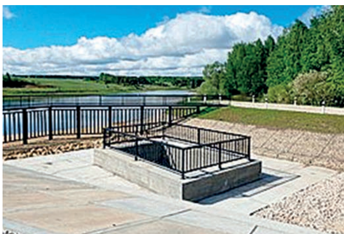
Капитальный ремонт ГТС у с. Нурлаты Зеленодольского района
