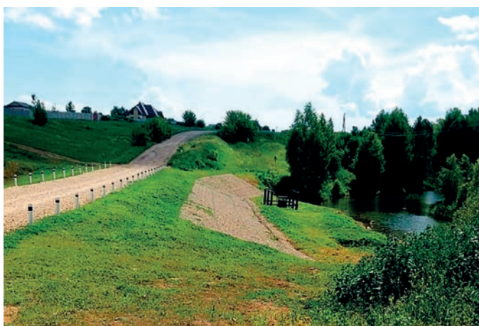
Капитальный ремонт ГТС у с. Ташкирмень Лаишевского района
