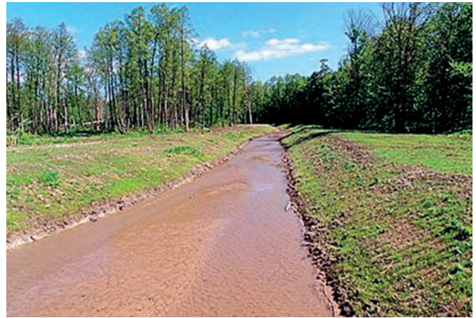
Расчистка и дноуглубление левого притока р. Меши в с. Бима Лаишевского муниципального района
